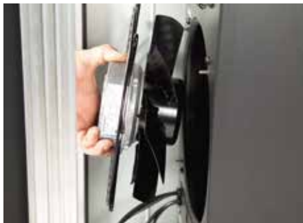
Simple fan replacement
